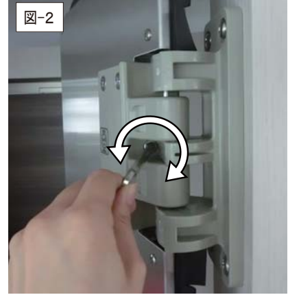
六角レンチで左右どちらかに回して調整。
