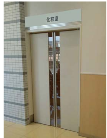
【商業施設】トイレ前室の間仕切り
