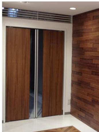
【商業施設】バックヤードとの間仕切り
